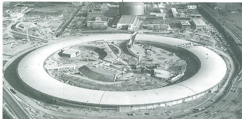
La source de rayonnement de l'ESRF est un anneau de stockage d'électrons ou de positrons de 850 m de circonférence (photo A. Childéric-A.M. Freund).
