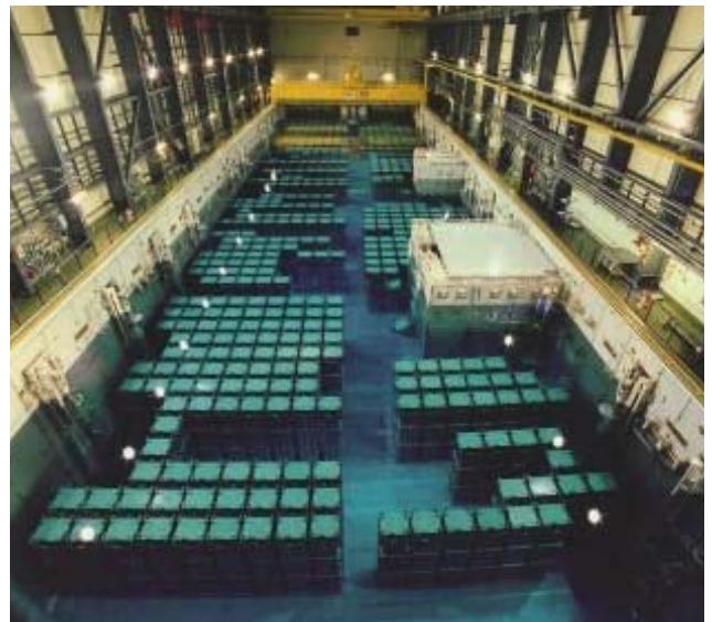
Piscine d'entreposage de l'usine COGEMA de La Hague, l'un des sites d'intervention de Millennium.
